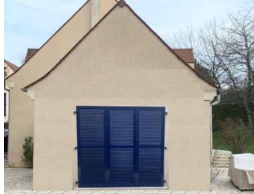
Pignon avec porte Fenêtre (Après)
